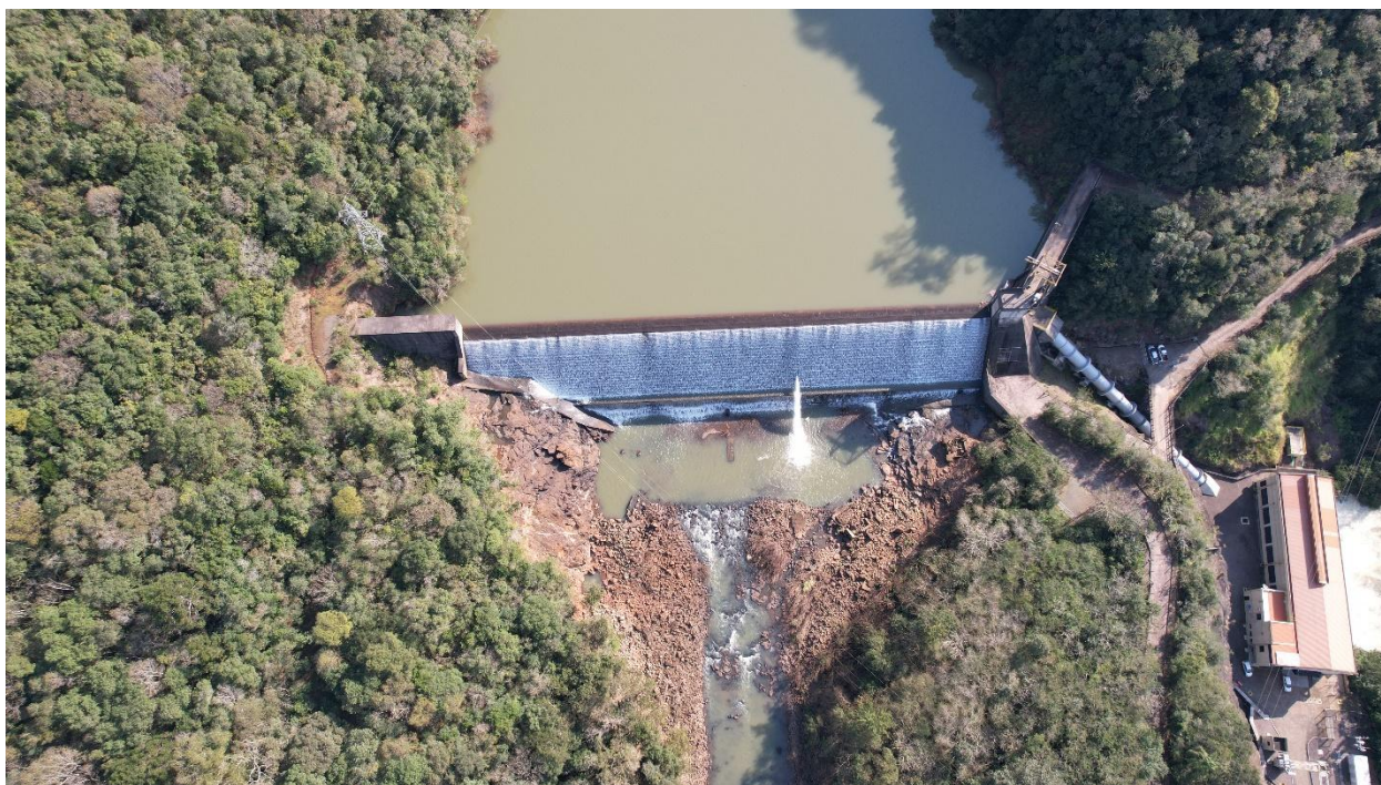
Figura 23 – Superfície do Vertedouro de soleira livre
